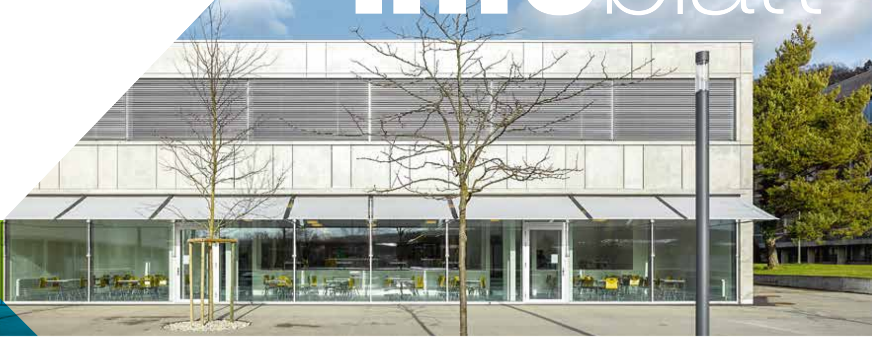
Das aufgestockte Mensagebäude fügt sich harmonisch in den Rychenberg-Campus ein. Foto: www.michaelhaug.ch
