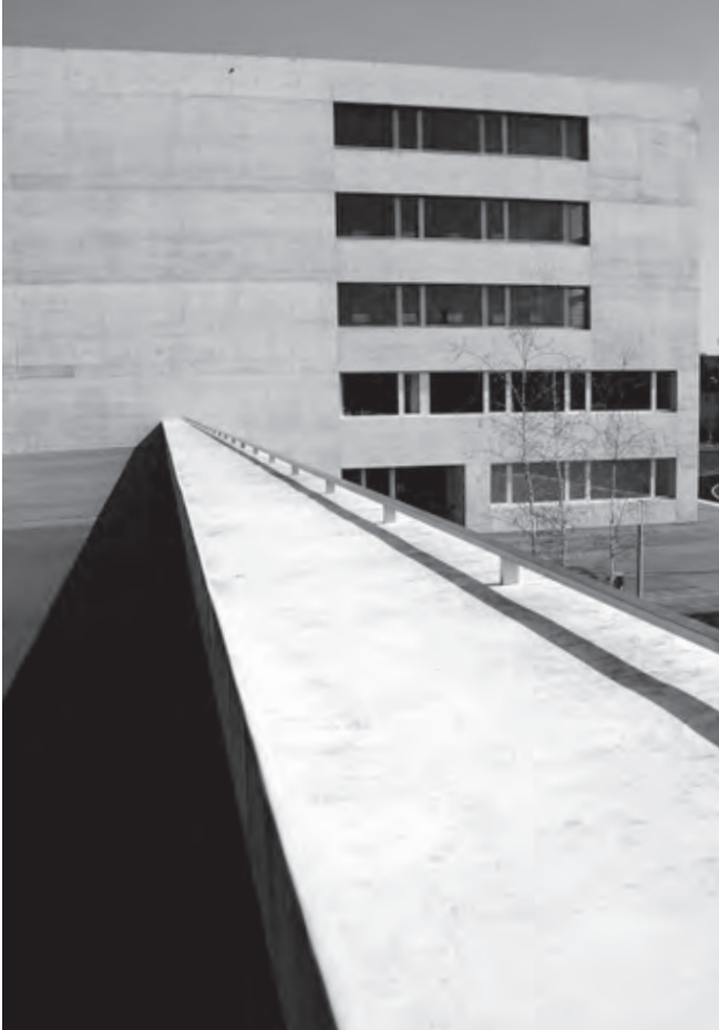
Turmgebäude (J. Haberland, 2007) von Westen.
