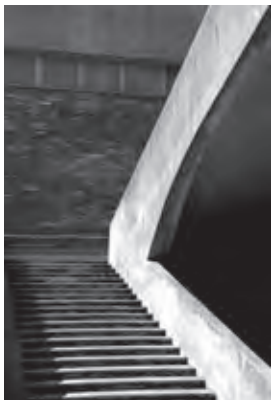
Neuer Treppenaufgang (Lanter) entlang den Turnhallen zur Kantonsschule Im Lee.
