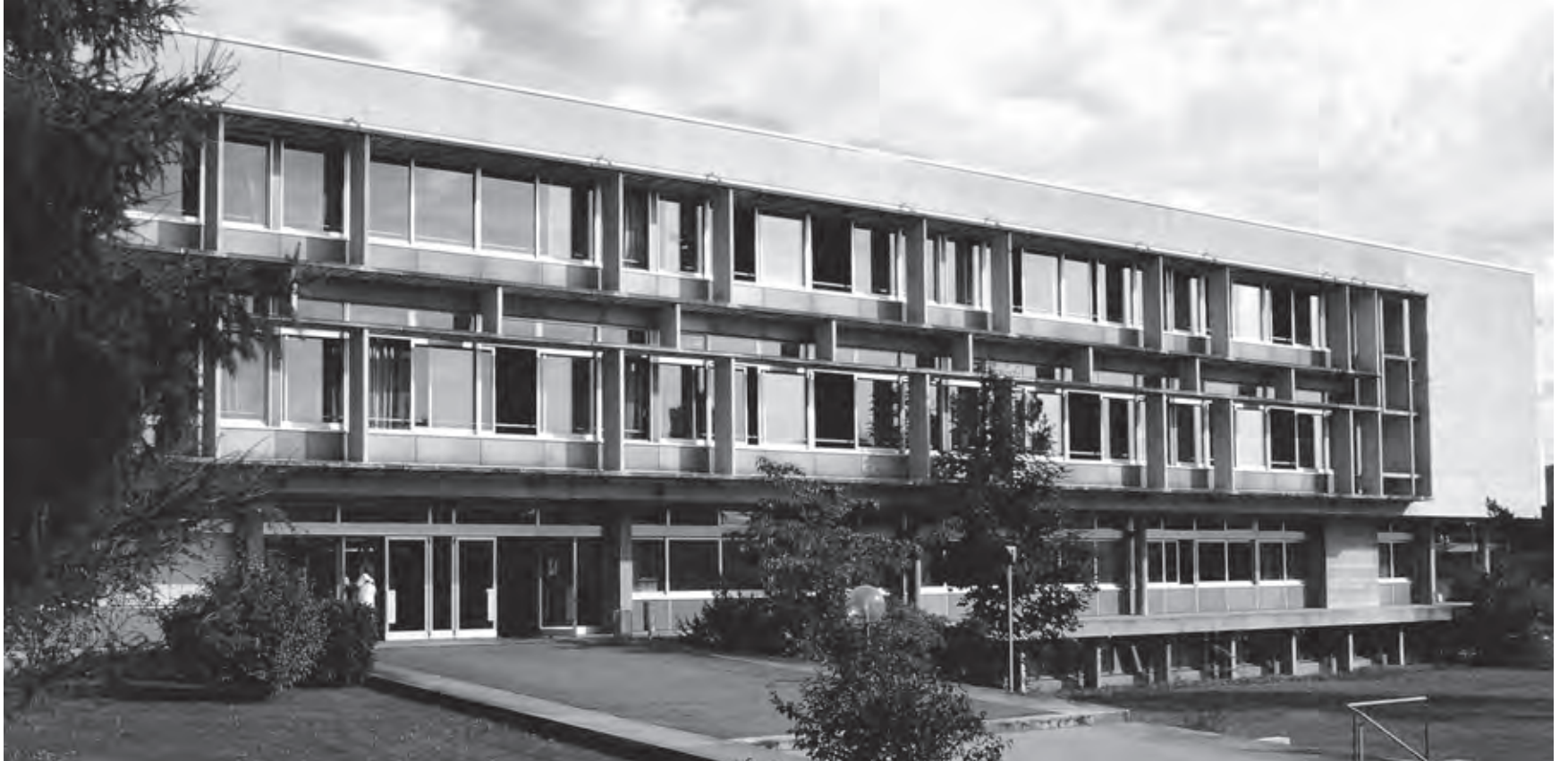
Hauptgebäude (Lanter) Westfassade mit Eingang (2009).
