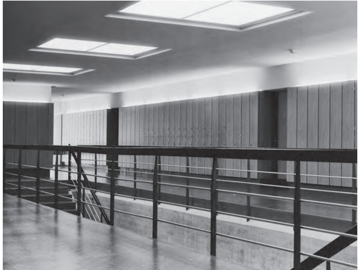
Südkorridor im 2. Geschoss mit Treppen; an der Decke Lichtschächte.
