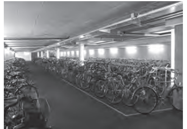
Unterirdische Abstellhalle für Fahrräder unter den Klassenzimmern (2007).
