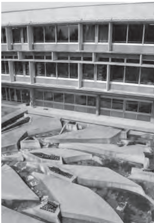
Hauptgebäude Ostfassade mit Brunnen.
