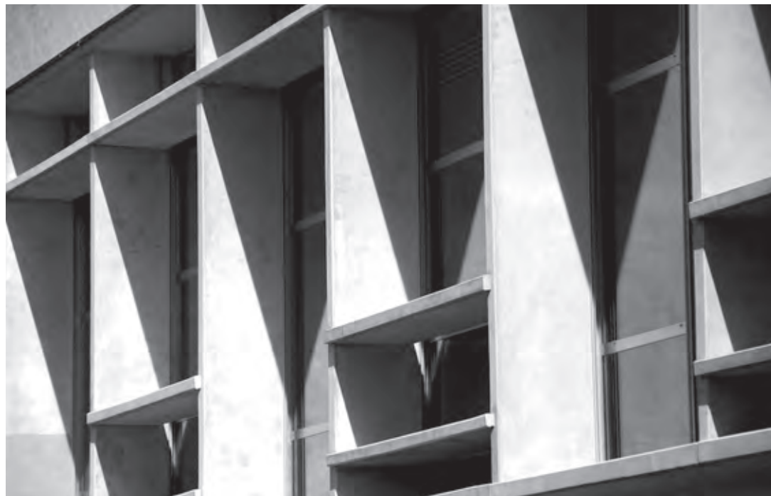
Turnhallen A + B Westfassade mit Brise-soleil.
