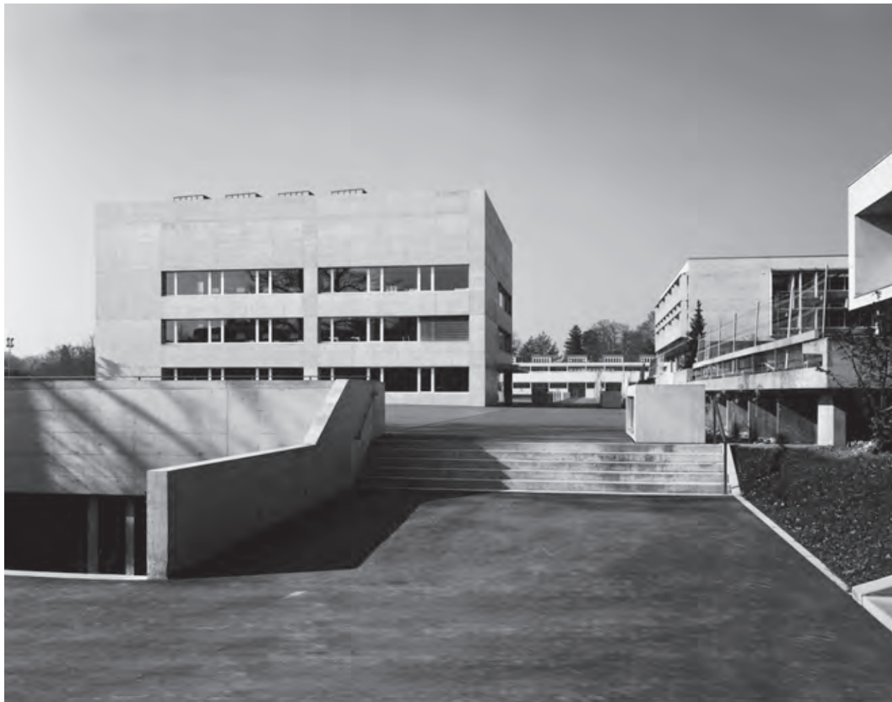
Erweiterungsbau 2007 von Osten.
